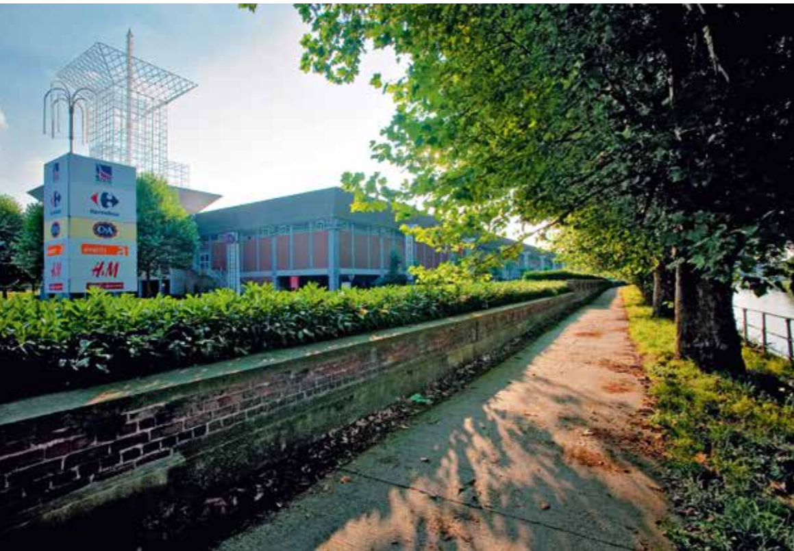
Centre commercial 'Belle-Ile' à Liège
