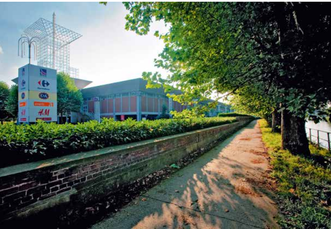
Centre commercial 'Belle-Ile' à Liège
