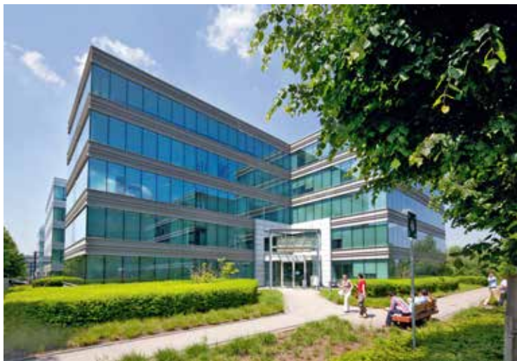
Office building Medialaan, Vilvoorde
