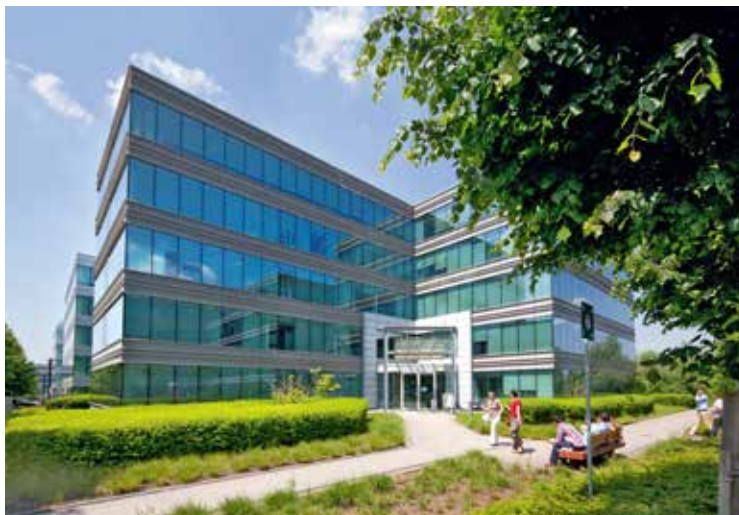
Kantoorgebouw Medialaan, Vilvoorde
